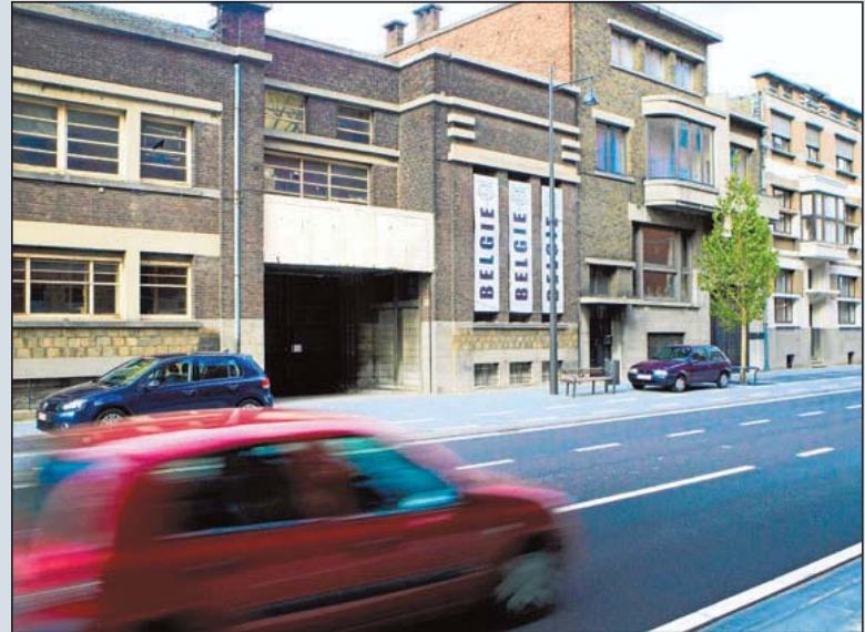
Huis Hoste en Koloniale Waren krijgen Vlaams geld voor renovatie.
